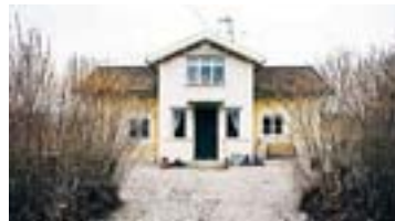
Boningshuset byggdes i början av 1700-talet som en timrad enkelstuga och putsades vid en ombyggnad på 1800-talet.
